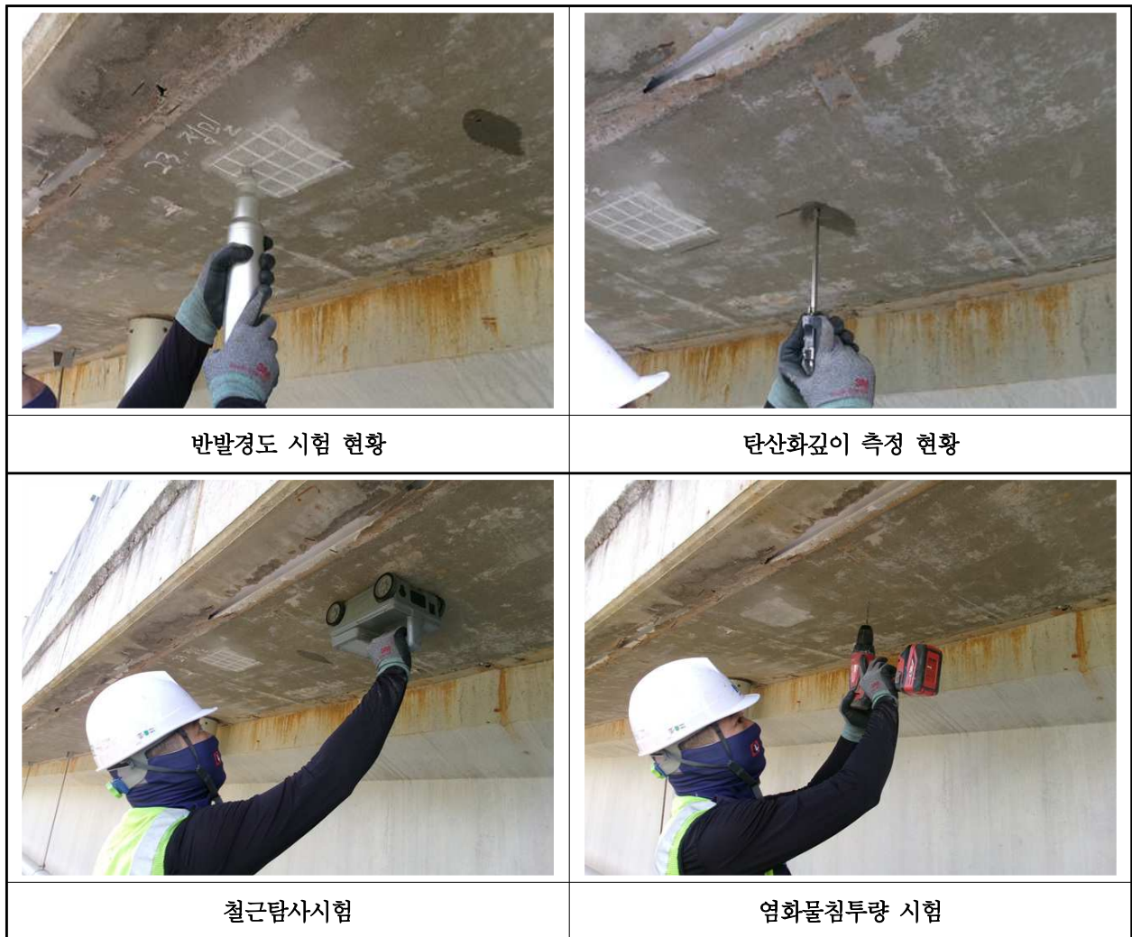
【사진 19.4.1】 콘크리트 내구성조사 현황
