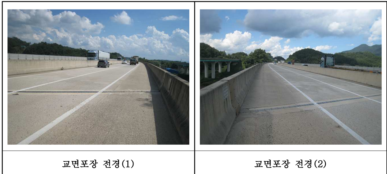
【사진 19.3.19】 교면포장 전경
