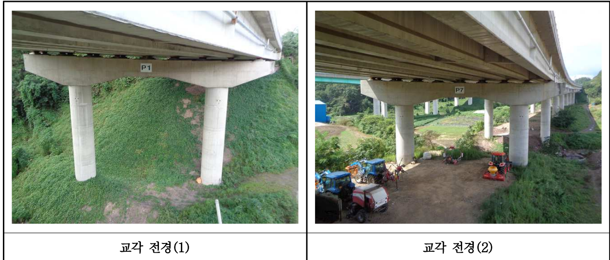
【사진 19.3.10】 교각 전경
