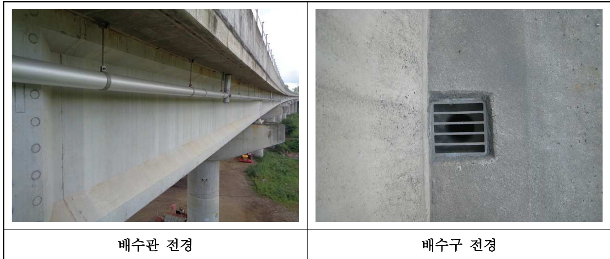
【사진 19.3.21】 배수시설 전경
