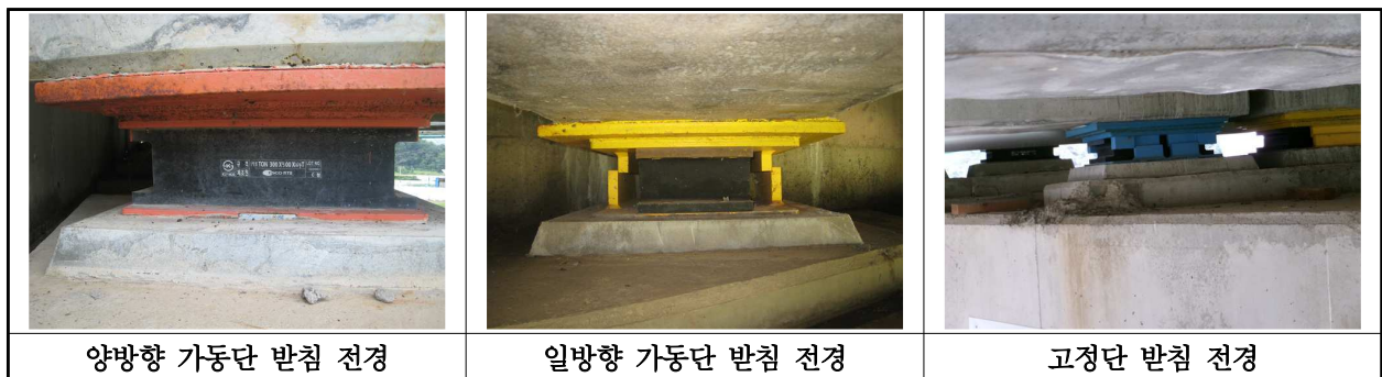
【사진 19.3.12】 교량받침 전경
