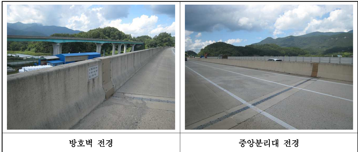
【사진 19.3.23】 방호벽 및 중앙분리대 전경
